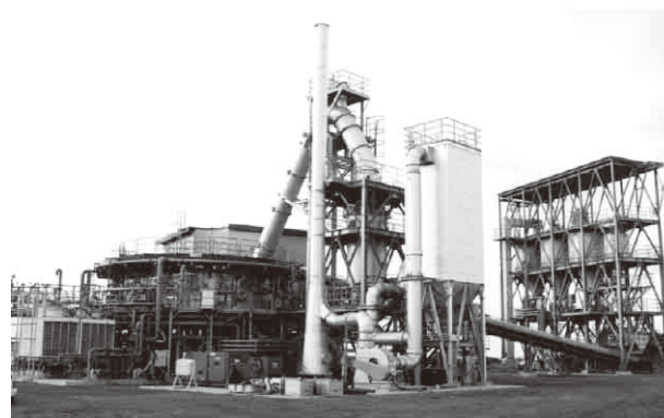
写真1 パイロットプラントの外観 Photo 1 Outline of the pilot plant
